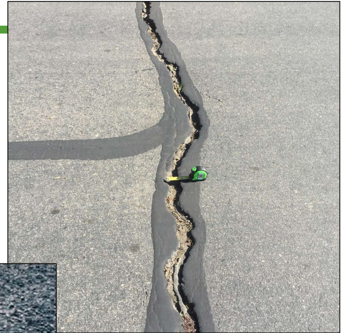
Thermal Crack
